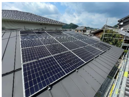
新築戸建て住宅
